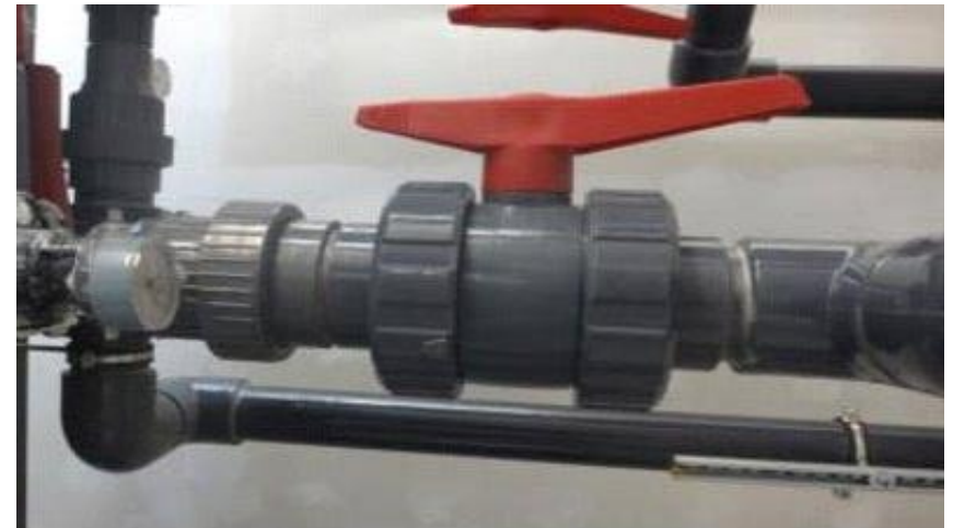
Замена прокладки в запорной арматуре.
