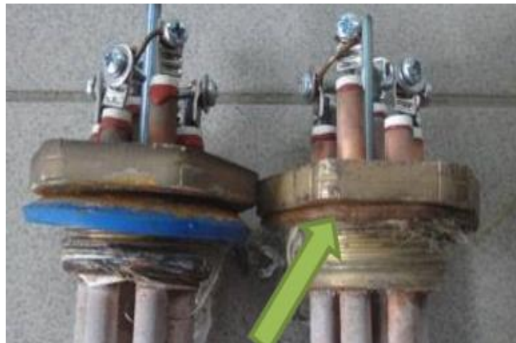
Замена прокладки в тэне водогрейного котла
