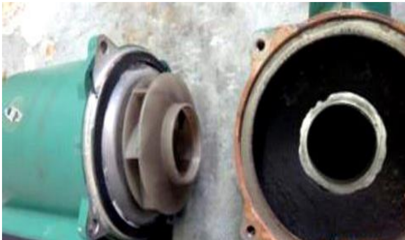
Замена прокладки в циркуляционном насосе
